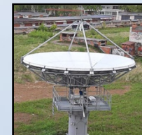
СПДП-АМ Диаметр антенны 7 м
